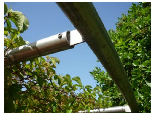
Rohre, Verbindungen und Spanndrähte aus Edelstahl
